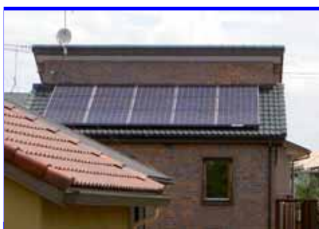
静岡市駿河区国吉田 Y 発電所 2.40 kW
