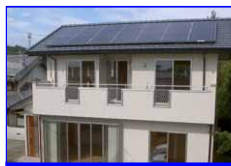
御前崎市塩原新田 S 発電所 3.21 kW
