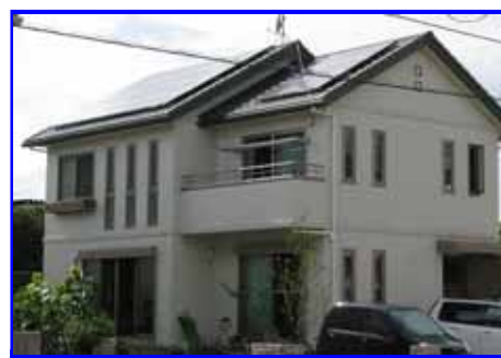
相模原市麻溝台 K 発電所 4.16 kW
