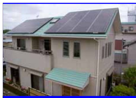
袋井市永楽町 K 発電所 4.96 kW
