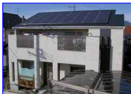
静岡市清水区追分 T 発電所 5.12 kW
