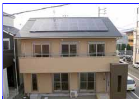
静岡市葵区千代田 K 発電所 3.84 kW
