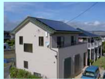
袋井市大野 K発電所 3.21 kW
