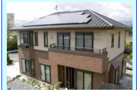
菊川市西方 S発電所 3.26 kW
