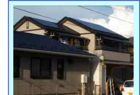
山梨県中巨摩郡 I 発電所 3.91 kW
