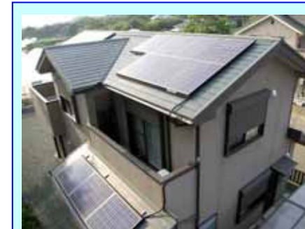
御前崎市池新田 K 発電所 2.77 kW
