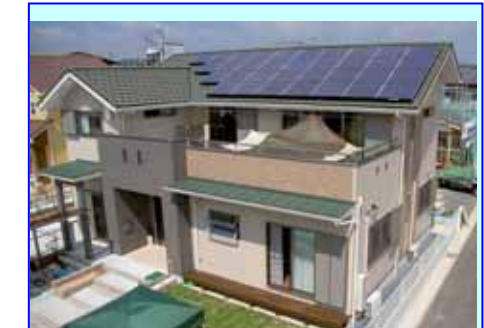
浜松市北区 H 発電所 5.44 kW
