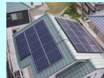
静岡市葵区 M 発電所 5.54kW
