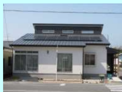
沼津市 Y発電所 4.30kW
