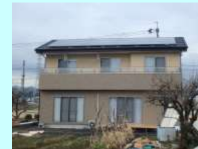
藤枝市 I発電所 4.92kW
