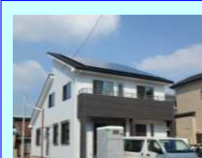
浜松市西区 K 発電所 6.15kW
