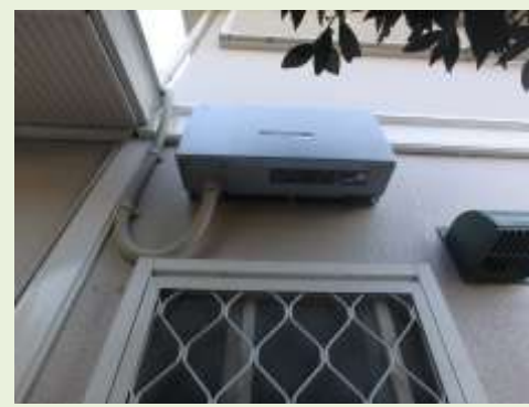
上：切妻屋根の南面に設置した5.94kWシステム 下：重塩害対応のパワーコンディショナ
