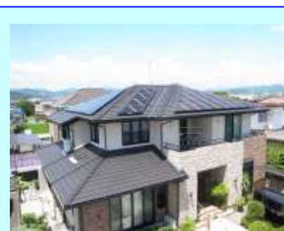
藤枝市 T 発電所 6.14kW
