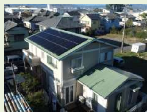
上：切妻屋根の南面に設置した5.94kWシステム 下：重塩害対応のパワーコンディショナ
