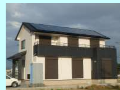
浜松市浜北区 K 発電所 4.92kW
