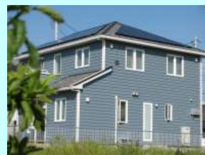
沼津市 K 発電所 4.90kW
